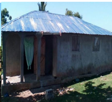
Fotka 3 : pohľad na dom po oprave
