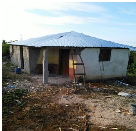
Pohľad po oprave domu
