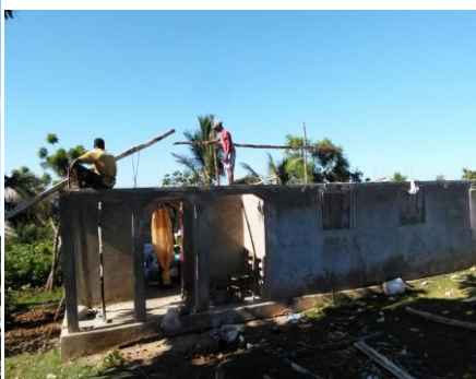
Fotka 2 : oprava strechy
