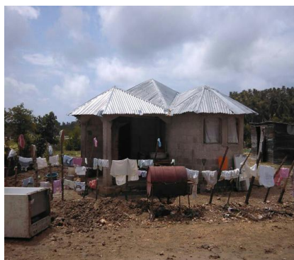
Pohľad po oprave domu
