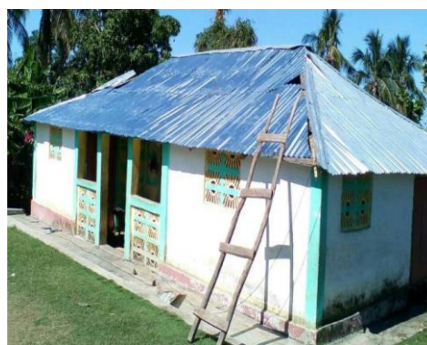
Pohľad po oprave domu
