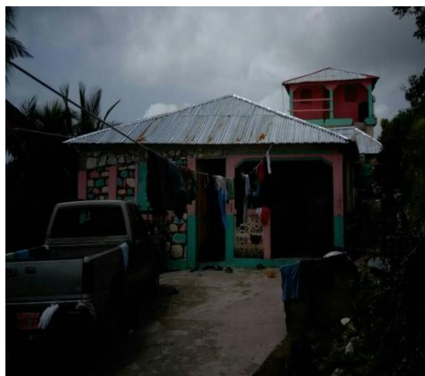
Pohľad po oprave domu
